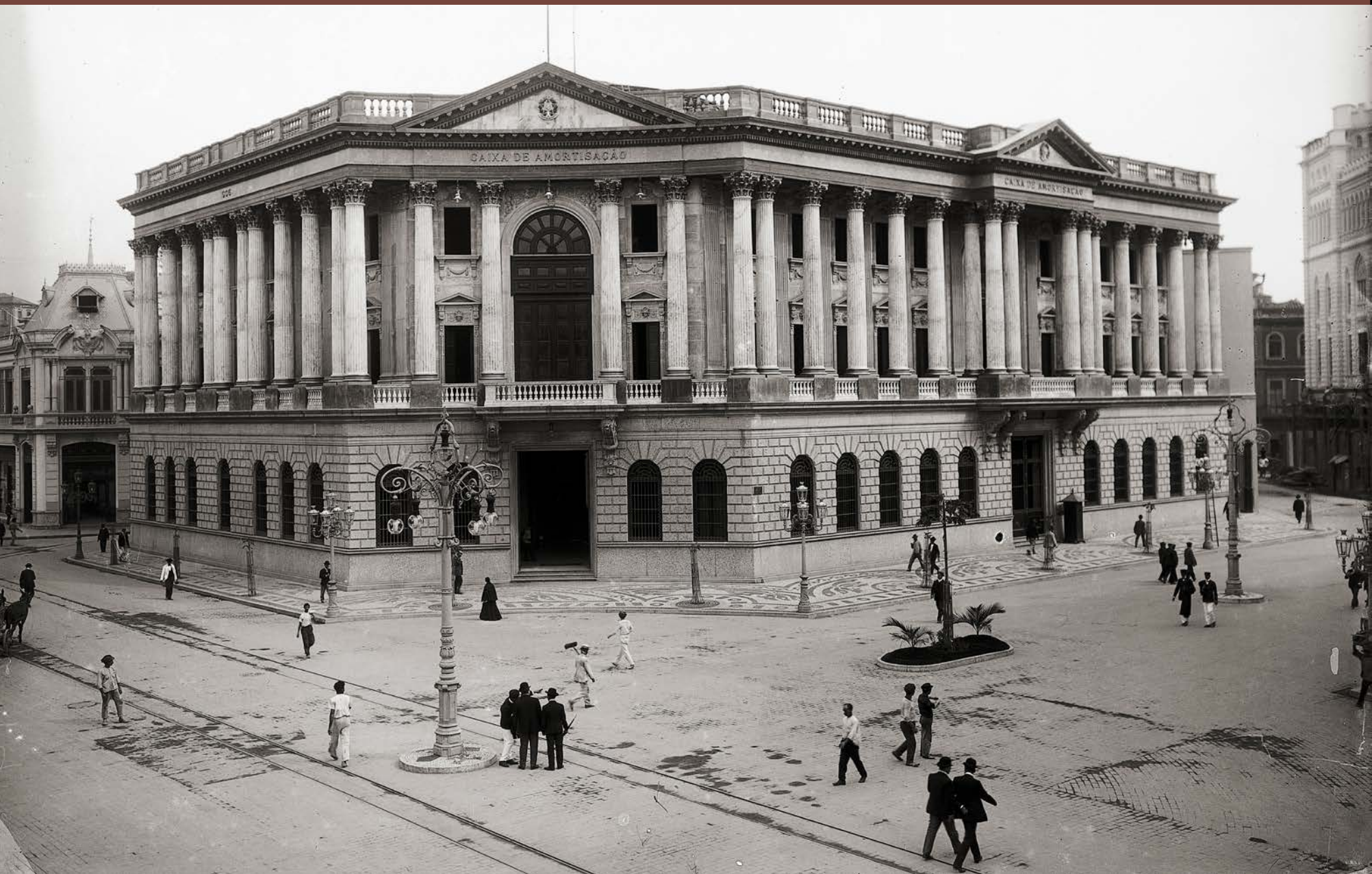
Caixa de Amortização (circa 1908), na Av. Rio Branco (RJ), onde foi instalado o Conselho de Contribuintes do Imposto do Consumo. Inaugurado em 1906, o prédio inspirado na faixa leste do Museu do Louvre, foi tombado nos anos 1970. Abriga hoje o Departamento de Meio Circulante (Mecir) do Banco Central do Brasil.
